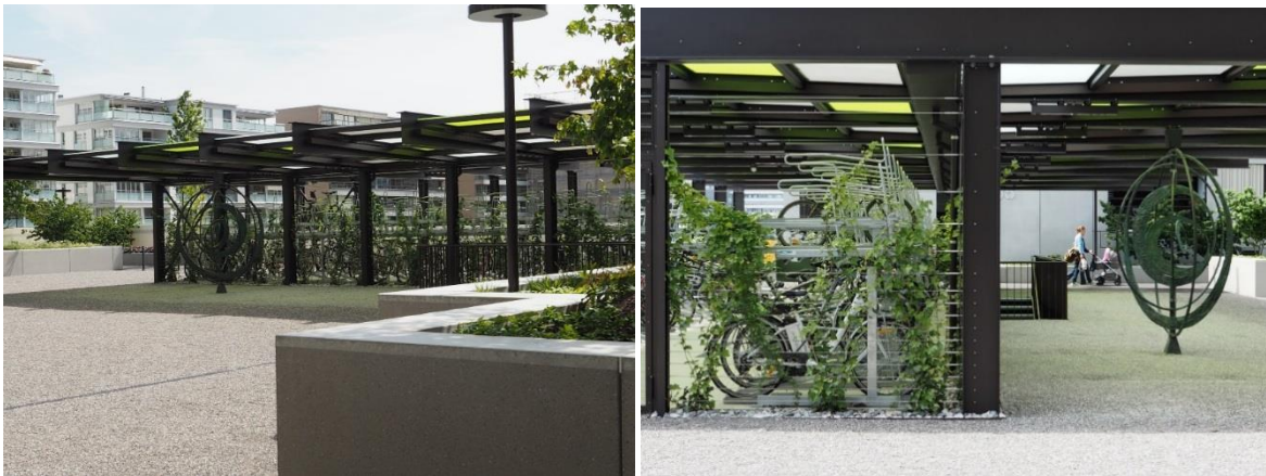
Abbildung 17: Fahrradgarage Neubaugebiet Zürich West
